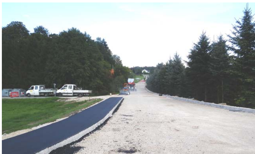
Das Foto zeigt den aktuellen Baufortschritt in der Ortschaft Dorf.
